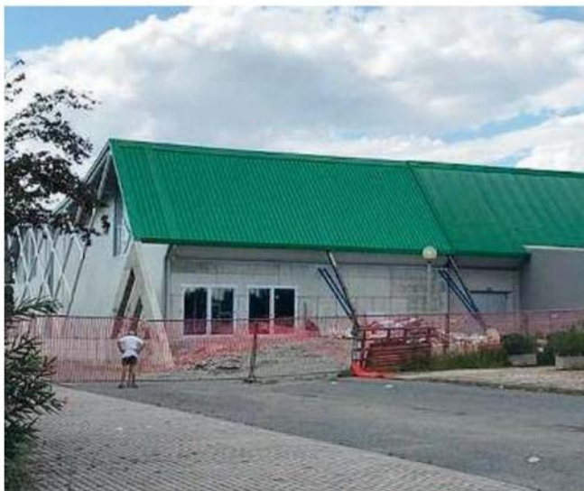
Palazzetto dello sport. Quasi ultimati i lavori per il PalaBertocchi
