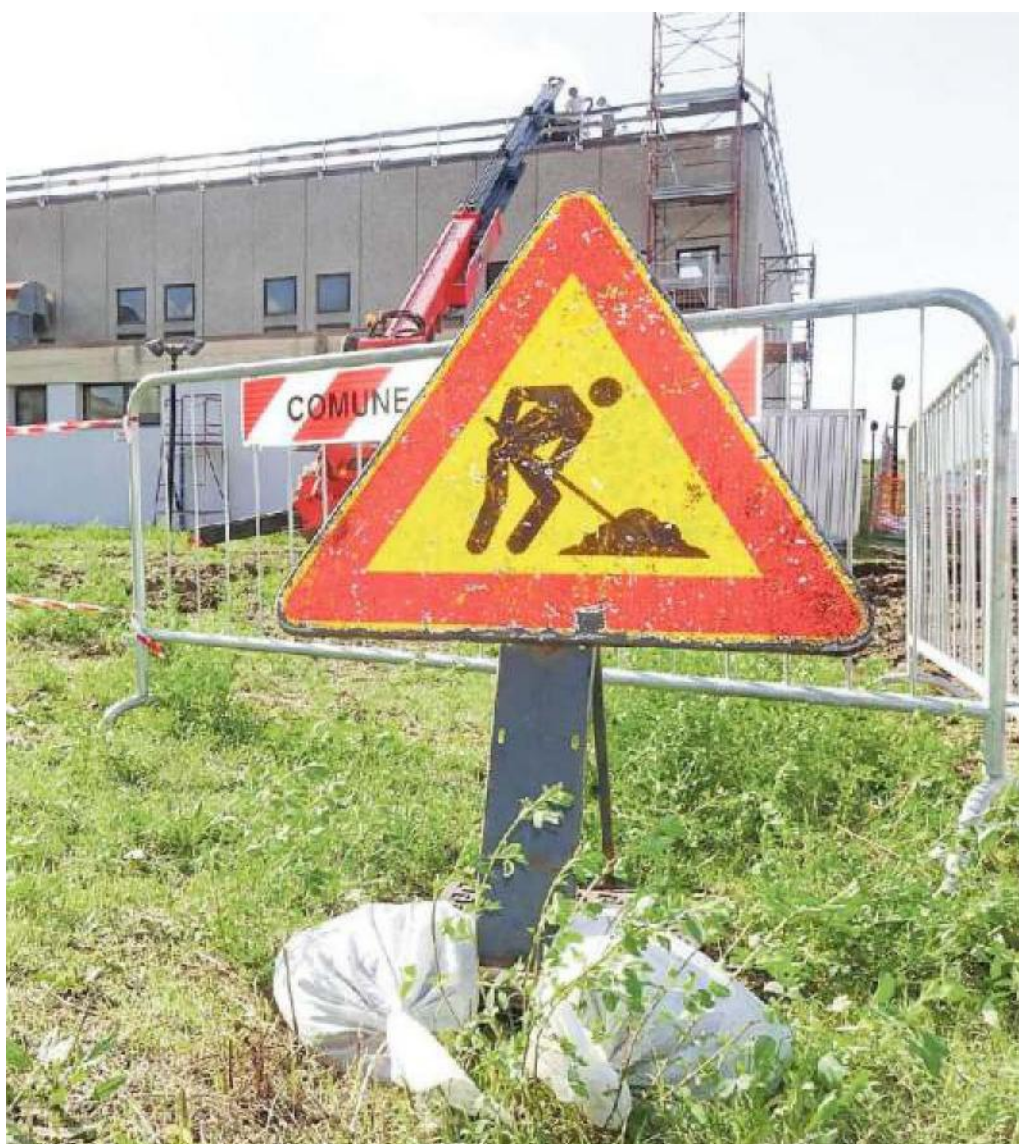
Lavori in corso al PalaCarrara già nel corso del 2019 FOTO GORI
