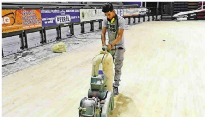
I lavori di levigatura del parquet al Palazzetto dello Sport
